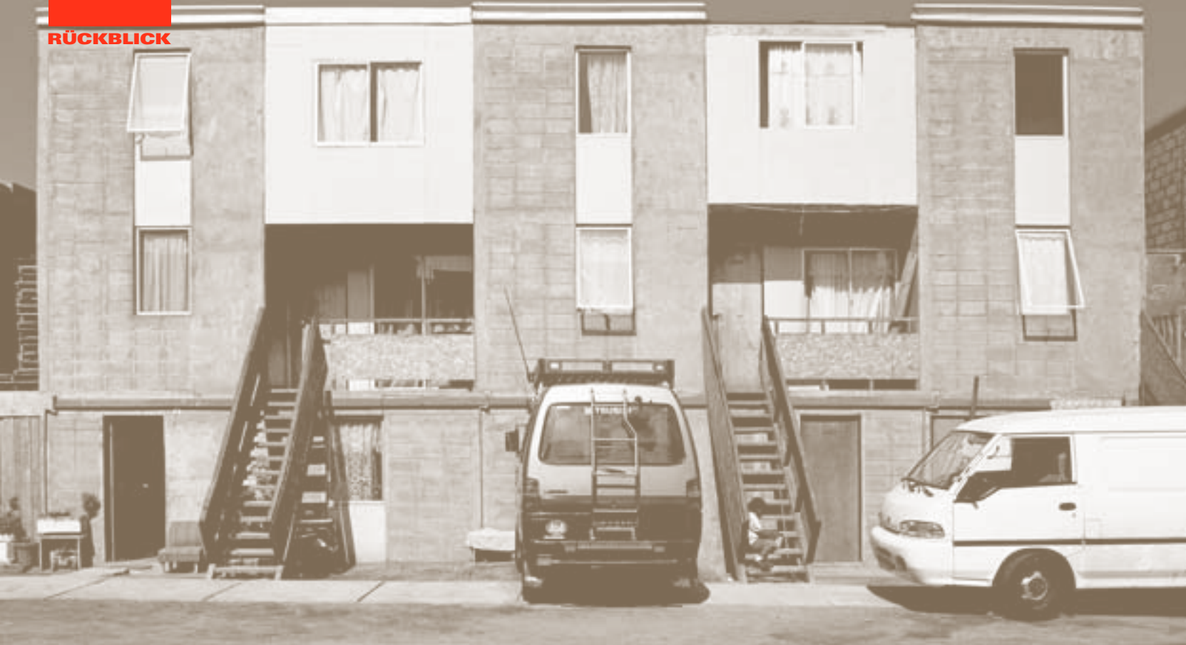
Sozialbau der Architektengruppe Elemental in Chile. Die Idee: kostengünstige Basisbauten, die die BewohnerInnen selbst erweitern. Foto: Cristobal Palma
