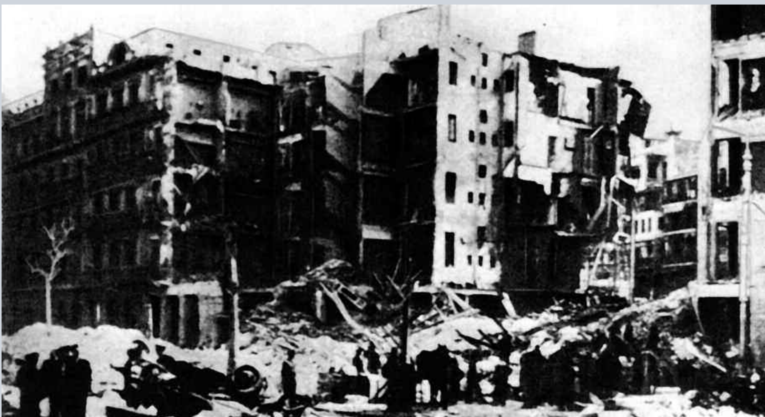
Zerstörte Wohnhäuser in Madrid nach einem Angriff der Legion Condor
